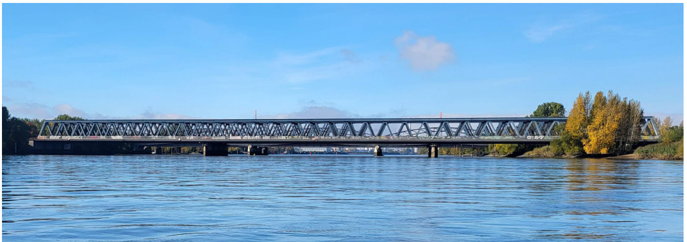
Abb. 1: Ansicht der Bestandsbrücke EÜ Süderelbe in Hamburg
